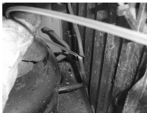
(2) コンプレッサー内の残留ガスのサンプリング
