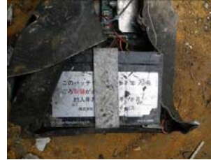
鉛バッテリー (UPS)
