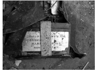
図 3.1.51 UPS(?) (バッテリー付属)
