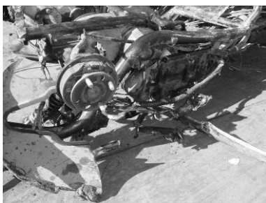
図 3.1.38 バッテリー架台 付近 (焼けが強い)
