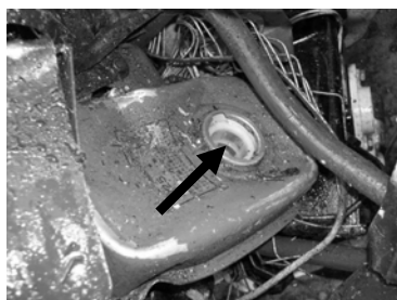
図 3.1.65 発電機給油口 フィルター（試料 H）
