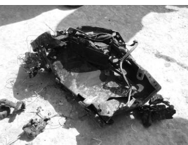
図 3.1.44 出火元と された UPS
