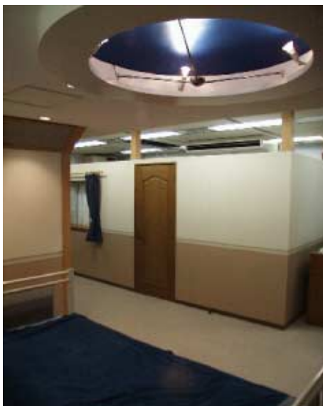
図 4: 部屋に設置されたドーム天井型マイクロフォン
