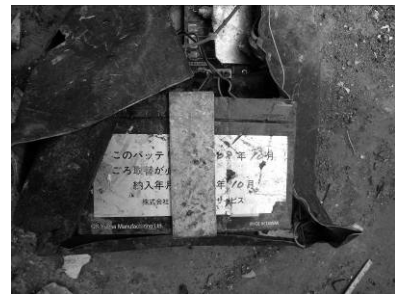
図3.1.15 UPS(?) (バッテリー付属)
