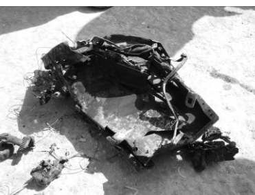
図3.1.8 出火元と されたUPS
