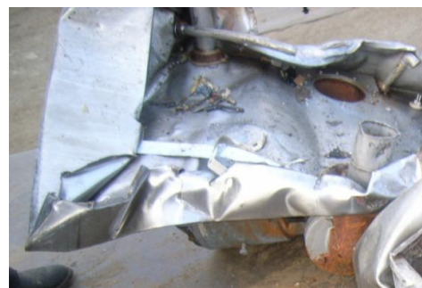
I-8 厨房機器
