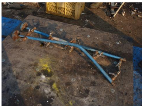
I-51 ガス配管
