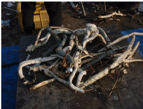
H-7 エアコン配管
