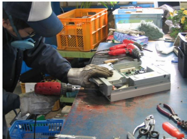
図 2.2.9 手解体の様子
